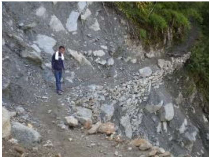
Stein für Stein wurde der neue Weg wieder aufgebaut.
